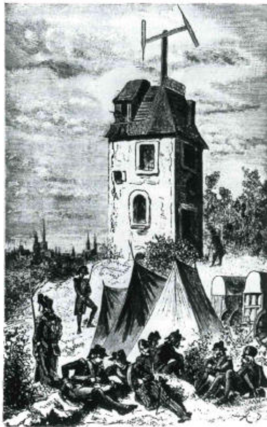
1 Damit die Zeigertelegraphen weithin sichtbar waren und bei Wind und Wetter bedient werden konnten, wurden hohe Türme gemauert. Auf diesen war dann die Stangenkonstruktion montiert.
