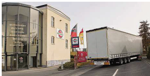
Die Stema Metallleichtbau GmbH an der Rieser Straße in Großenhain schafft Platz durch den Abriss von vier Gebäuden. Foto: Kristin Richter
