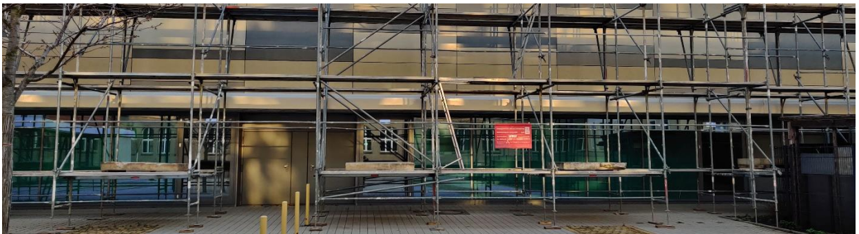
(Aufnahme vom 01.04.2021 – Gerüst an der Turnhalle in Cotta – JK)
