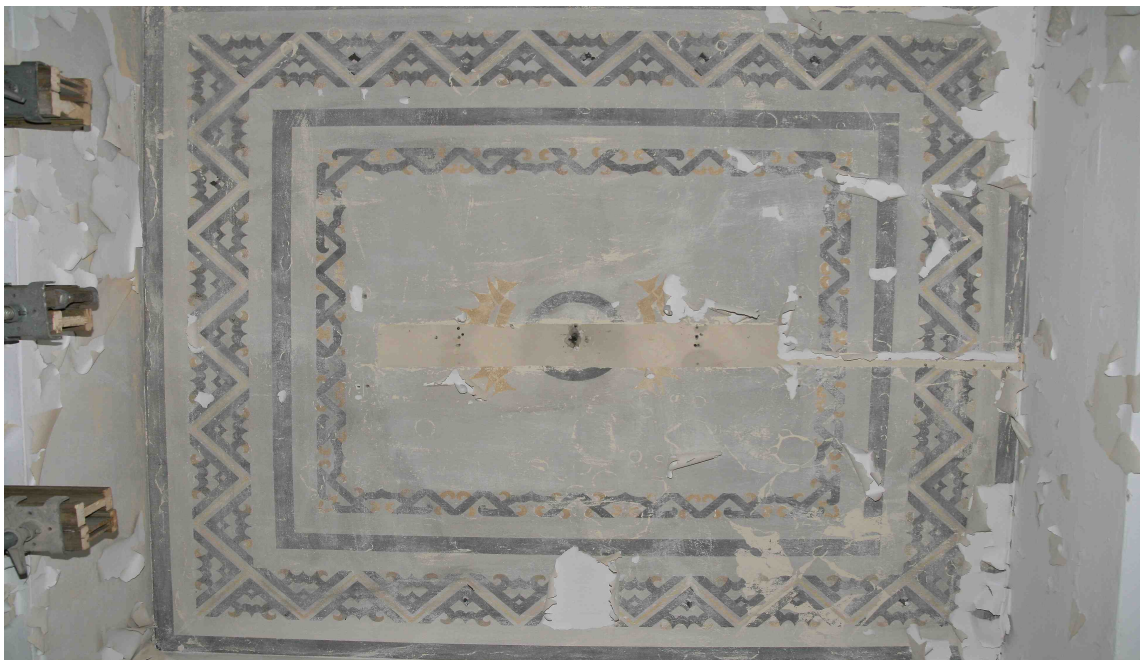
Zustand der Decke vor der Restaurierung 1
