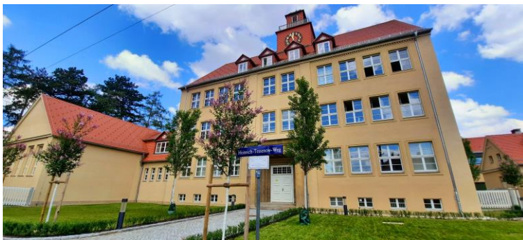
Altbau mit Blick auf die Turnhalle
